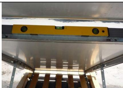
Posizionare una livella sulla superficie orizzontale superiore del collettore e verificare che l'installazione sia completamente parallela al piano di terra.
