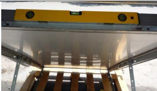
Posizionare una livella sulla superficie orizzontale superiore del collettore e verificare che l'installazione sia completamente parallela al piano di terra.
