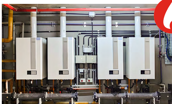
MODULI A CONDENSAZIONE
